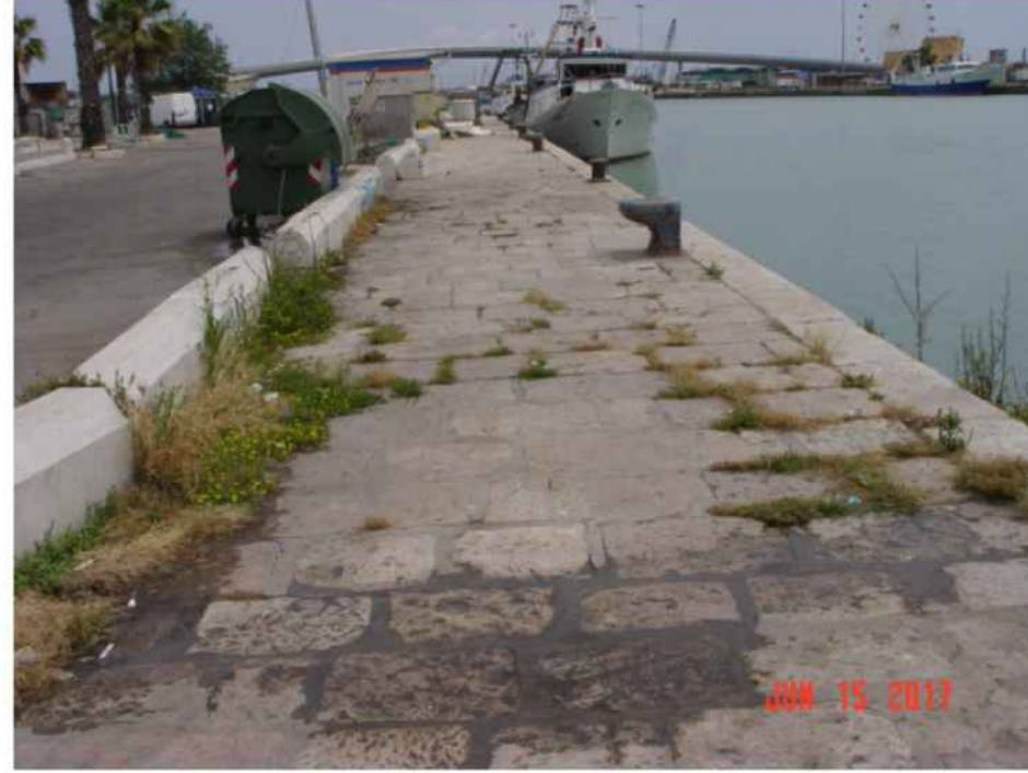
particolare degrado della pietra di trani di banchina: in evidenza lacune, macchie oleose, vegetazione infestante
