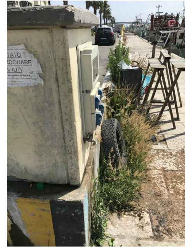
particolari sull'alto degrado della banchina nord: in evidenza vegetazione infestante, dissuasori in pietra di travertino divelti, degrado delle lastre in pietra di trani della banchina, rottura lacuna nel bordo di banchina, accumulo di vario materiale ed immondizia per insufficienza di appositi contenitori
