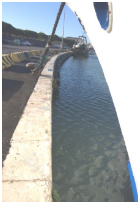
Figura 11-12 banchina sud - dettagli bordo di banchina privi di parabordi
