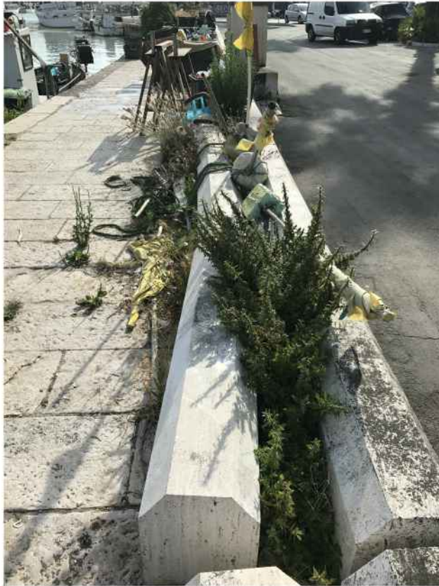
particolari sull'alto degrado della banchina nord: in evidenza vegetazione infestante, dissuasori in pietra di travertino divelti, degrado delle lastre in pietra di trani della banchina, accumulo di vario materiale ed immondizia per insufficienza di appositi contenitori
