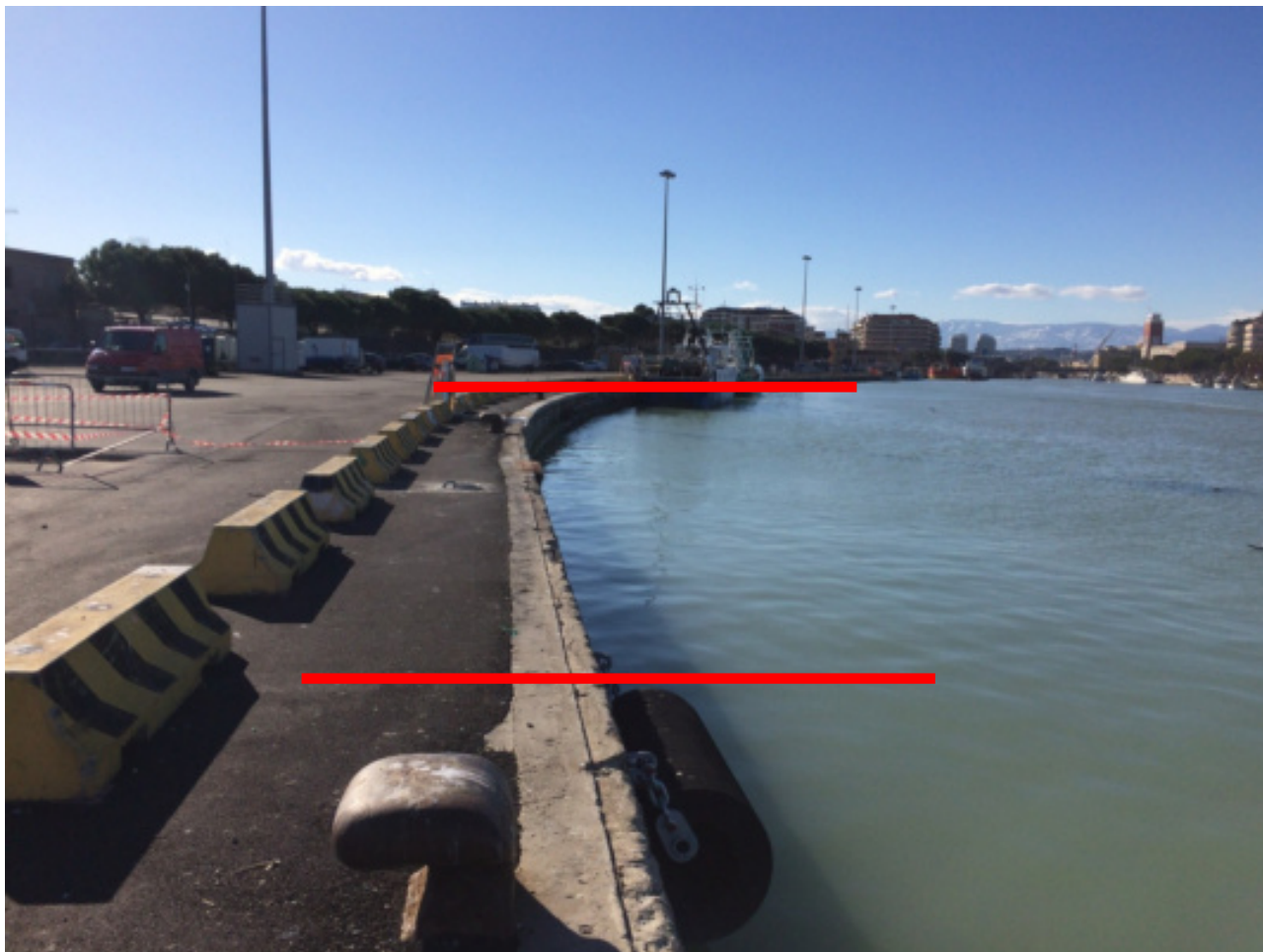
BANCHINA SUB: dettaglio tratto B ml 39.00 privo di parabordi
