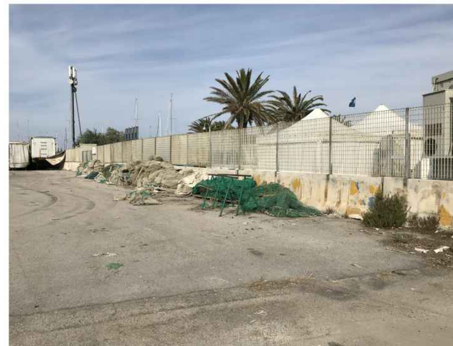
particolari sulle condizioni di degrado della banchina: manto bituminoso con diffuse aree ammalorate, macchie oleose, accumuli di materiale ferrosi, vari rifiuti provenienti da lavorazioni
