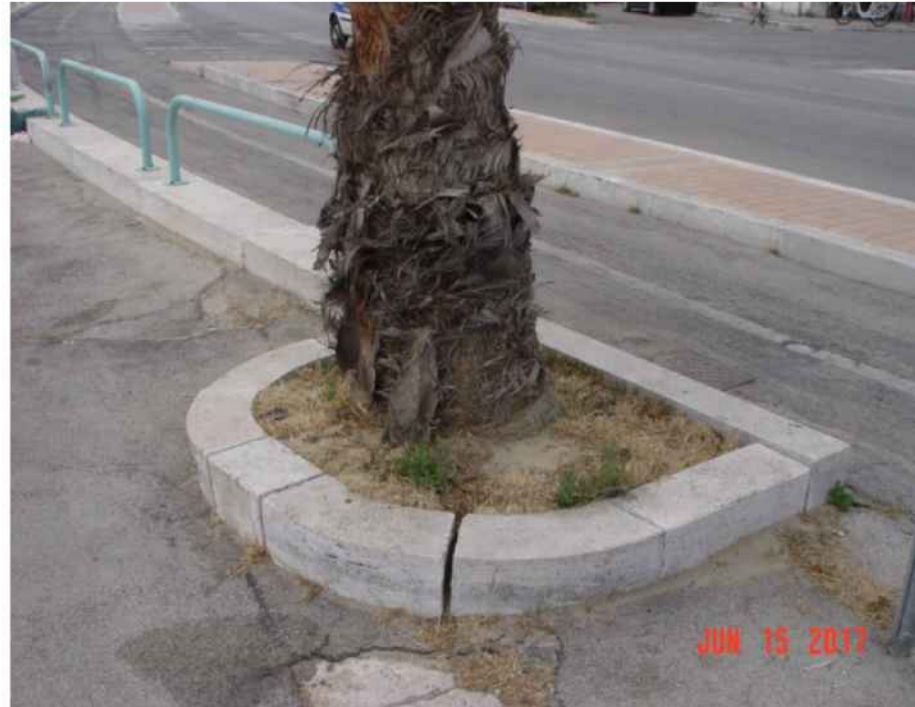
particolari sui coronamenti in travertino delle aiuole: blocchi in disesto dalla sede d'impianto
