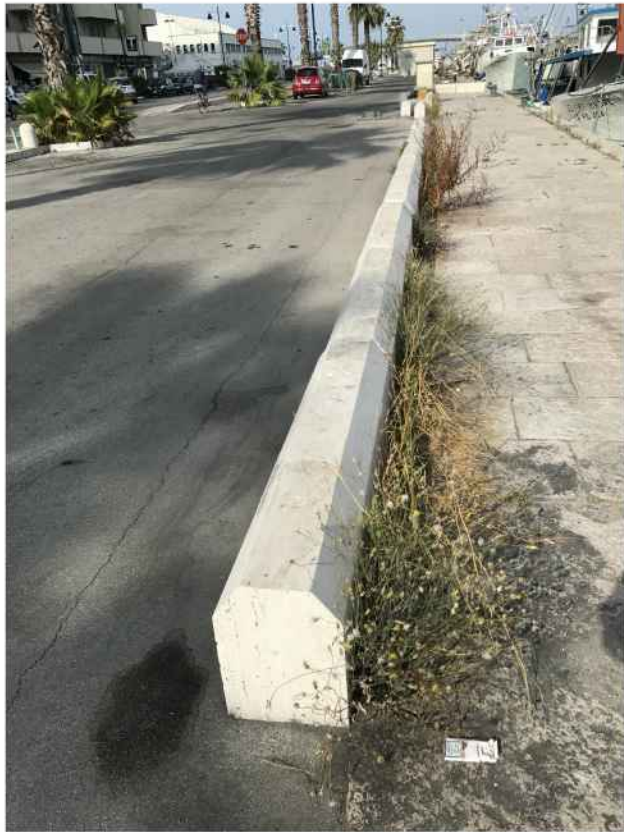
particolari sull'alto degrado della banchina nord: in evidenza vegetazione infestante, dissuasori in pietra di travertino divelti, degrado delle lastre in pietra di trani della banchina, accumulo di vario materiale ed immondizia per insufficienza di appositi contenitori
