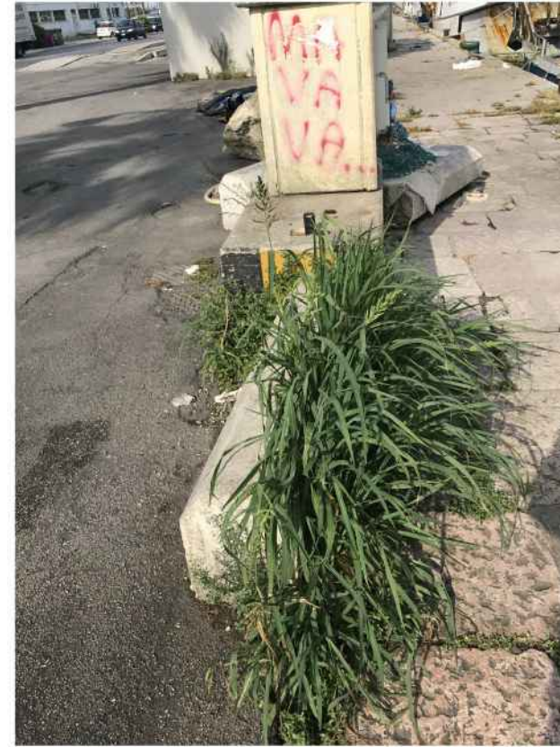
particolari sull'alto degrado della banchina nord: in evidenza vegetazione infestante, dissuasori in pietra di travertino divelti, degrado delle lastre in pietra di trani della banchina, rottura lacuna nel bordo di banchina, accumulo di vario materiale ed immondizia per insufficienza di appositi contenitori
