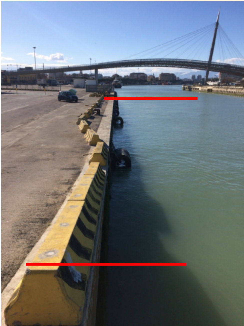
BANCHINA SUB: dettaglio tratto A ml 21.00 privo di parabordi
