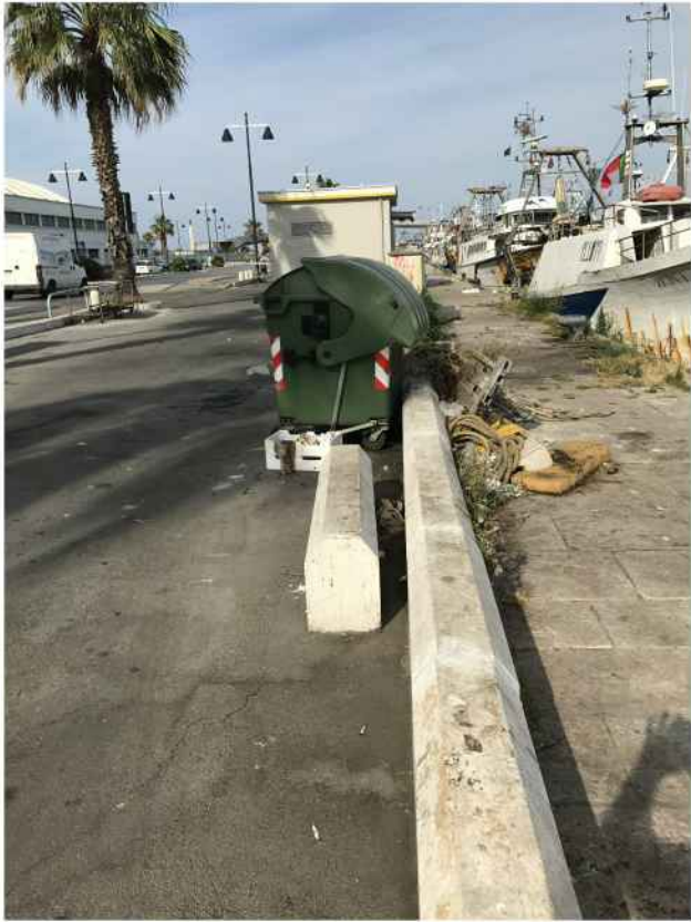
particolari sull'alto degrado della banchina nord: in evidenza vegetazione infestante, dissuasori in pietra di travertino divelti, degrado delle lastre in pietra di trani della banchina, rottura lacuna nel bordo di banchina, accumulo di vario materiale ed immondizia per insufficienza di appositi contenitori
