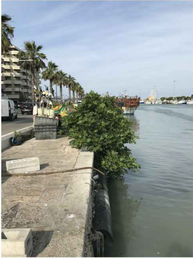
particolari sull'alto degrado della banchina nord: in evidenza vegetazione infestante, dissuasori in pietra di travertino divelti, degrado delle lastre in pietra di trani della banchina, accumulo di vario materiale ed immondizia per insufficienza di appositi contenitori
