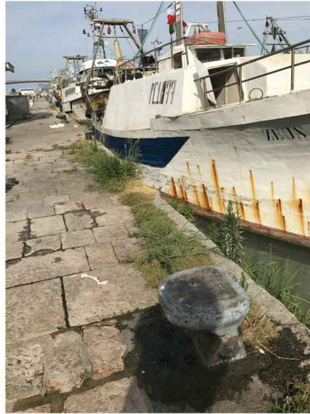
particolari sull'alto degrado della banchina nord: in evidenza vegetazione infestante, dissuasori in pietra di travertino divelti, degrado delle lastre in pietra di trani della banchina, rottura lacuna nel bordo di banchina, accumulo di vario materiale ed immondizia per insufficienza di appositi contenitori
