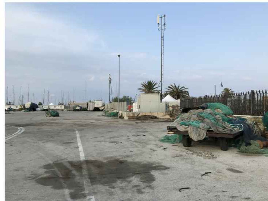
particolari sulle condizioni di degrado della banchina: manto bituminoso con diffuse aree ammalorate, macchie oleose, accumuli di materiale ferrosi, vari rifiuti provenienti da lavorazioni
