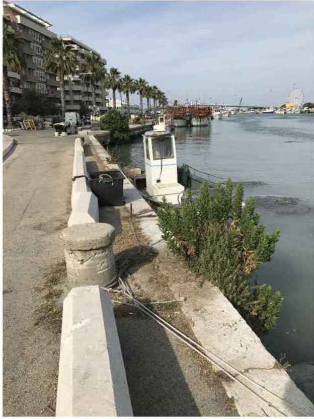
particolari sull'alto degrado della banchina nord: in evidenza vegetazione infestante, dissuasori in pietra di travertino divelti, degrado delle lastre in pietra di trani della banchina, accumulo di vario materiale ed immondizia per insufficienza di appositi contenitori
