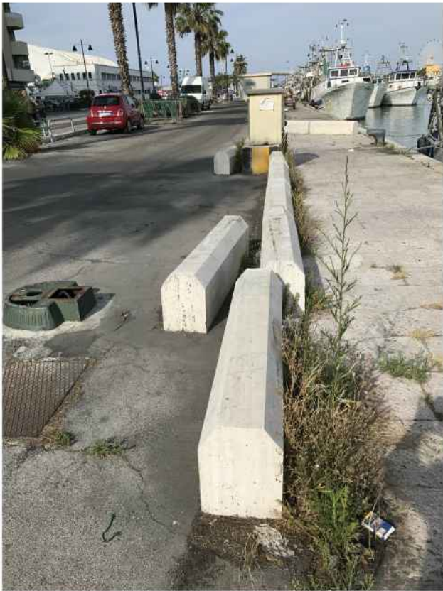
particolari sull'alto degrado della banchina nord: in evidenza vegetazione infestante, dissuasori in pietra di travertino divelti, degrado delle lastre in pietra di trani della banchina, accumulo di vario materiale ed immondizia per insufficienza di appositi contenitori
