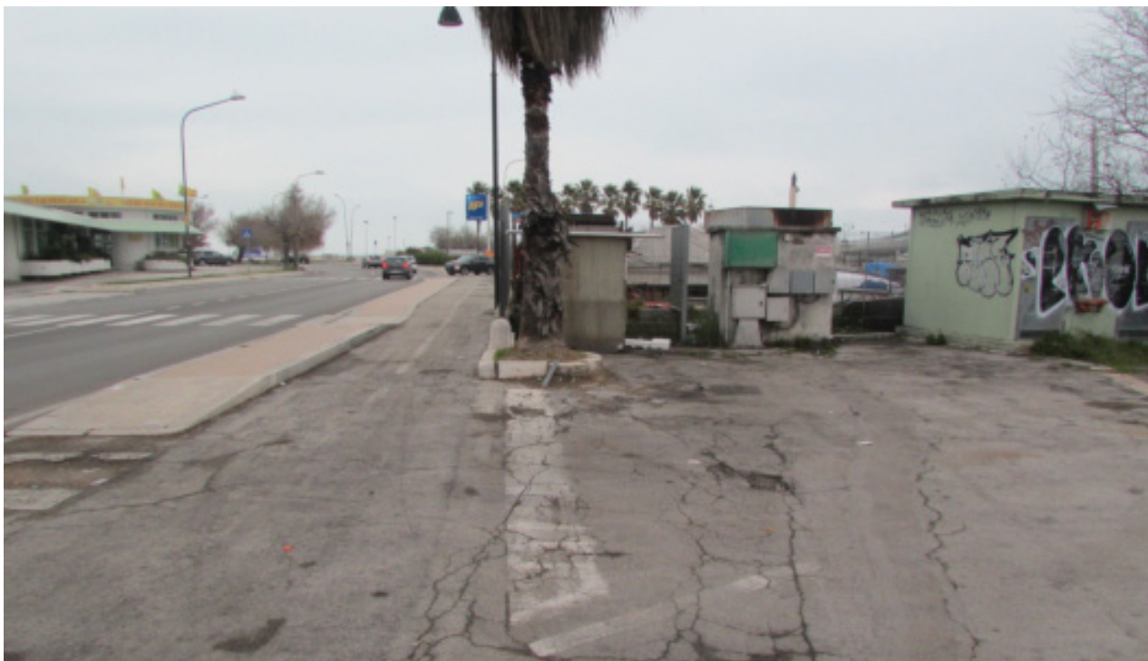
Figura 9 banchina nord - dettagli degrado del trappetino d'usura
