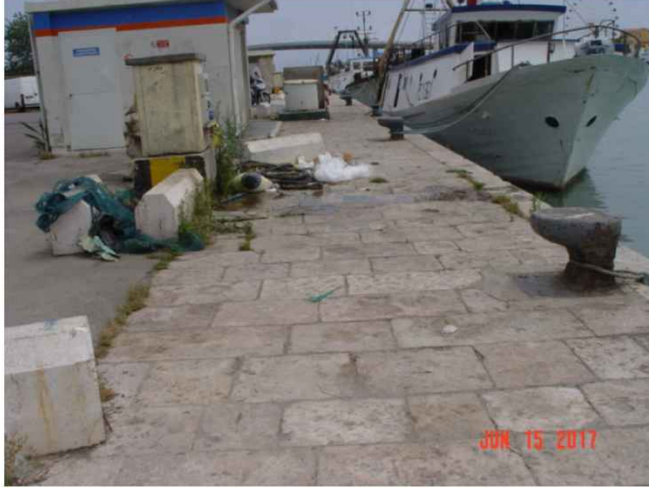
particolare degrado della banchina: in evidenza accumulo di vari rifiuti e dissuasori in pietra di travertino divelti dalla loro sede di separazione
