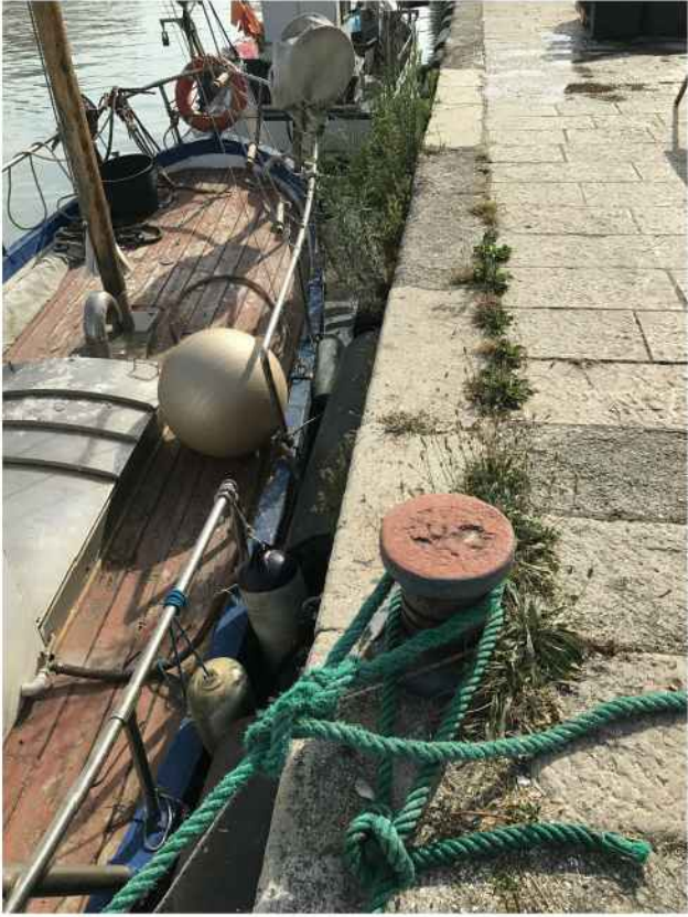
particolari sull'alto degrado della banchina nord: in evidenza vegetazione infestante, dissuasori in pietra di travertino divelti, degrado delle lastre in pietra di trani della banchina, accumulo di vario materiale ed immondizia per insufficienza di appositi contenitori
