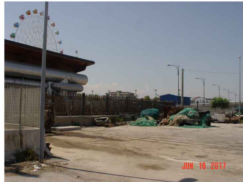
particolari sulle condizioni di degrado della banchina: manto bituminoso con diffuse aree ammalorate, macchie oleose, accumuli di materiale ferrosi, vari rifiuti provenienti da lavorazioni
