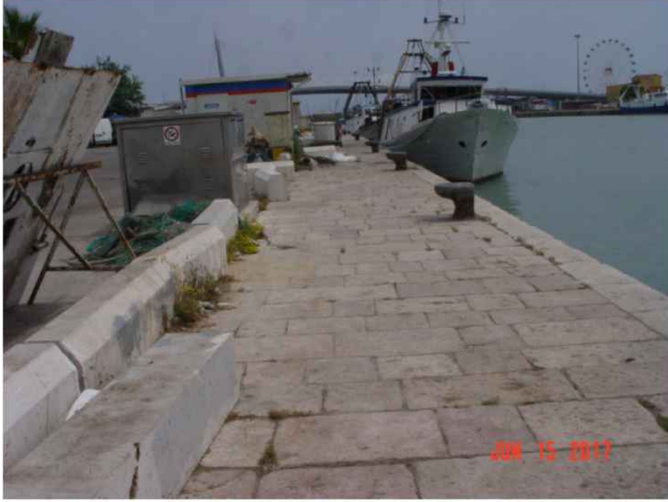
particolare degrado della pietra di trani di banchina: in evidenza dissuasori in pietra di travertino divelti dalla loro sede
