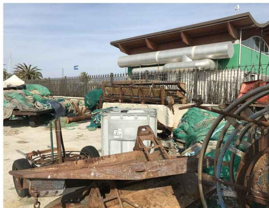
particolari sulle condizioni di degrado della banchina: manto bituminoso con diffuse aree ammalorate, macchie oleose, accumuli di materiale ferrosi, vari rifiuti provenienti da lavorazioni
