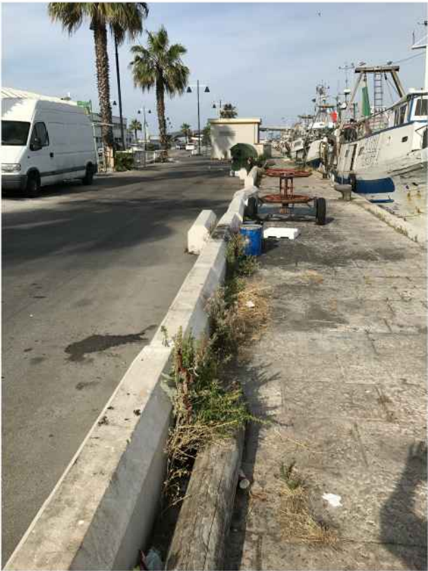
particolari sull'alto degrado della banchina nord: in evidenza vegetazione infestante, dissuasori in pietra di travertino divelti, degrado delle lastre in pietra di trani della banchina, accumulo di vario materiale ed immondizia per insufficienza di appositi contenitori
