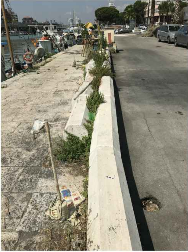
particolari sull'alto degrado della banchina nord: in evidenza vegetazione infestante, dissuasori in pietra di travertino divelti, degrado delle lastre in pietra di trani della banchina, accumulo di vario materiale ed immondizia per insufficienza di appositi contenitori
