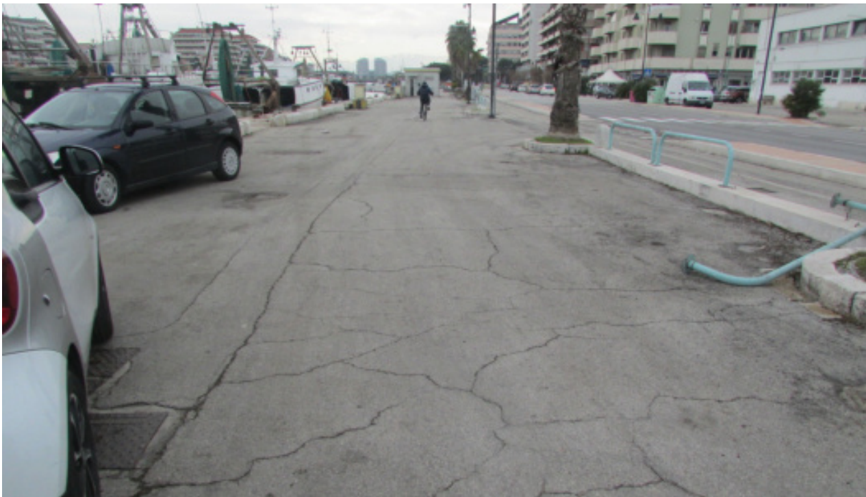
Figura 9 banchina nord - dettagli degrado del trappetino d'usura
