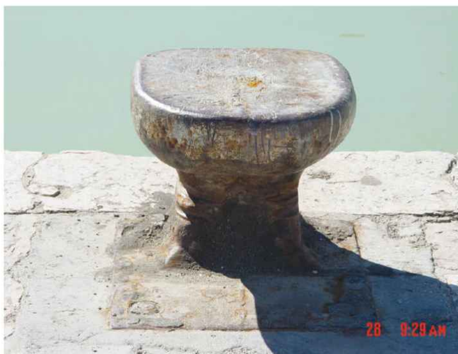
particolari sulle condizioni di degrado delle bitte di ormeggio
