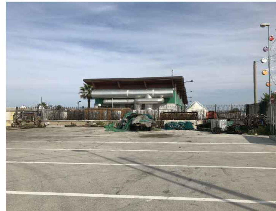
particolari sulle condizioni di degrado della banchina: manto bituminoso con diffuse aree ammalorate, macchie oleose, accumuli di materiale ferrosi, vari rifiuti provenienti da lavorazioni
