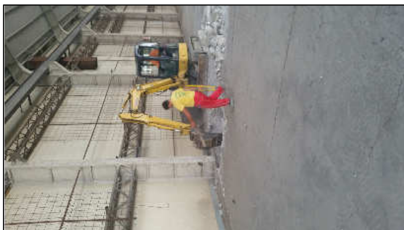
Foto n. 6: esecuzione trincea esplorativa T. E. 2
