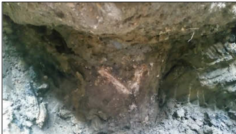
Foto n. 3: palo di fondazione trincea esplorativa T. E. 1
