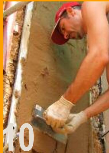
6> La prima campionatura di intonaco finita. 7> La realizzazione della seconda campionatura. 8> La preparazione del fondo per la realizzazione della terza campionatura. 9> La stesura dei vari strati di intonaco per la terza, e quarta campionatura. 10> La stesura dello strato di finitura della terza campionatura.
