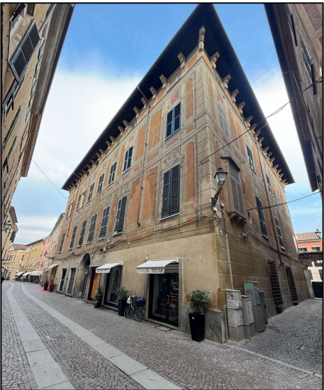
PALAZZO ADORNO E RESIDENZE NOBILIARI DI VIA GIRARDENGO
