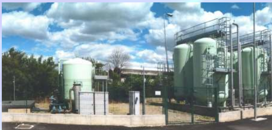
Bonifica della Ex Chimica Bianchi SpA – Rho (MI) - Portata: 270 m 3 /h - 4 filtri GAC \Phi=3.000 mm
